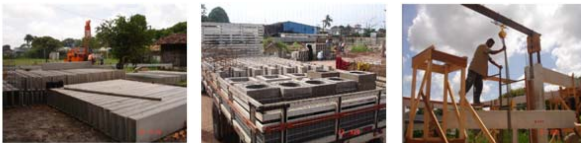
Figura 2.6 - Armazenagem, transporte e montagem de elementos pré-formados
