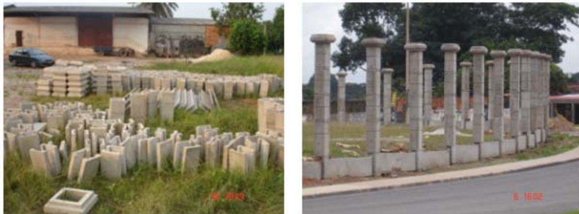
Figura 2.13 - Muro do Parque Ambiental de Belém em elementos pré-formados
