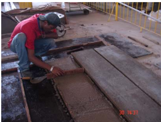
Figura 3.31 – Concretagem da segunda etapa (lateral 2)
