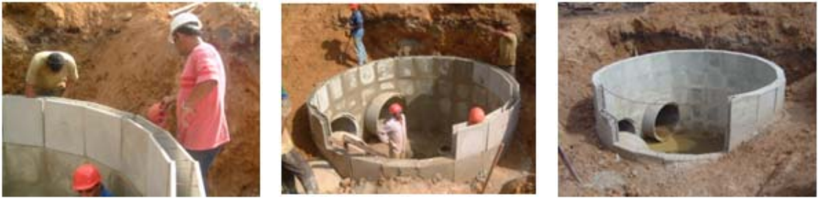
Figura 2.11 - Poço de visita em elementos pré-formados
