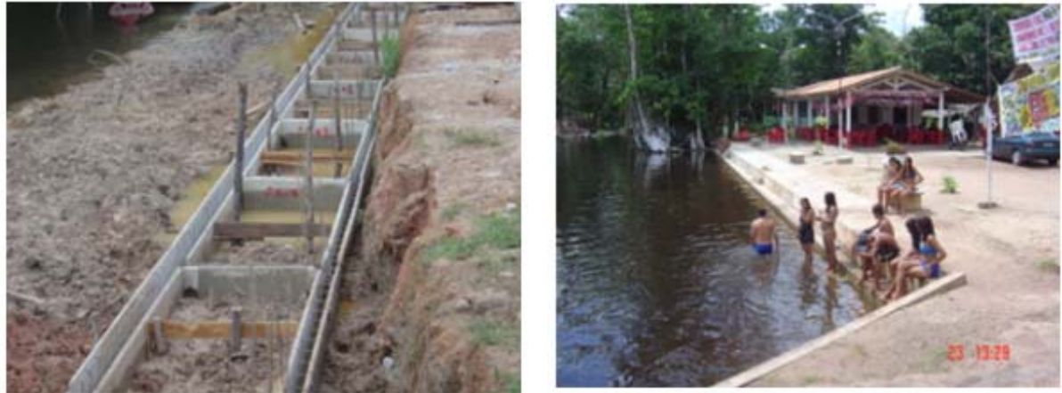
Figura 2.12 - Arrimo em elementos pré-formados em Benevides-PA
