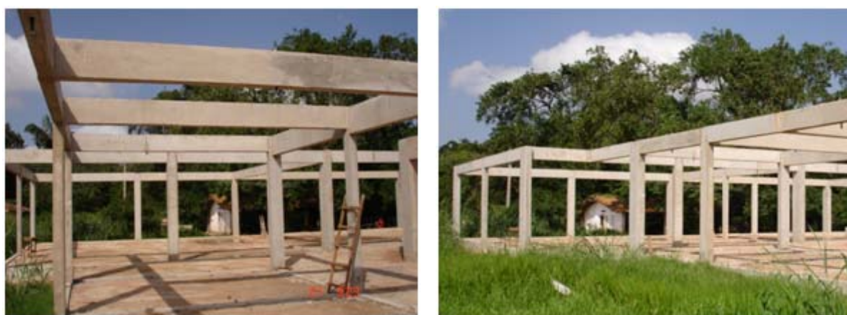
Figura 2.10 - Estrutura pré-formada de uma escola em Belém - PA
