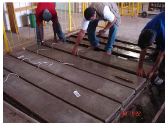
Figura 3.31 – Concretagem da segunda etapa (lateral 2)
