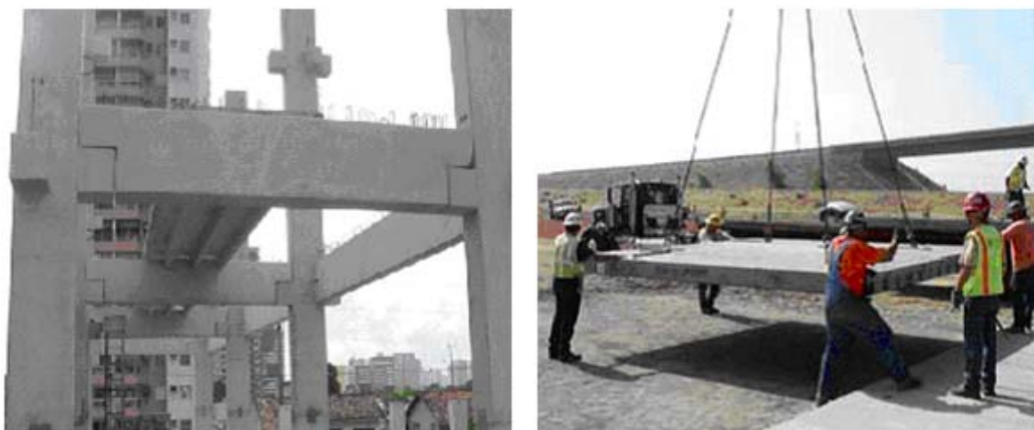
Figura 2. 2 - Montagem de estruturas pré-moldadas (SILVA FILHO et al., 2006)
