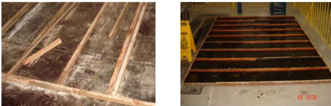
Figura 3.27 – Detalhes da forma das vigas pré-formadas
