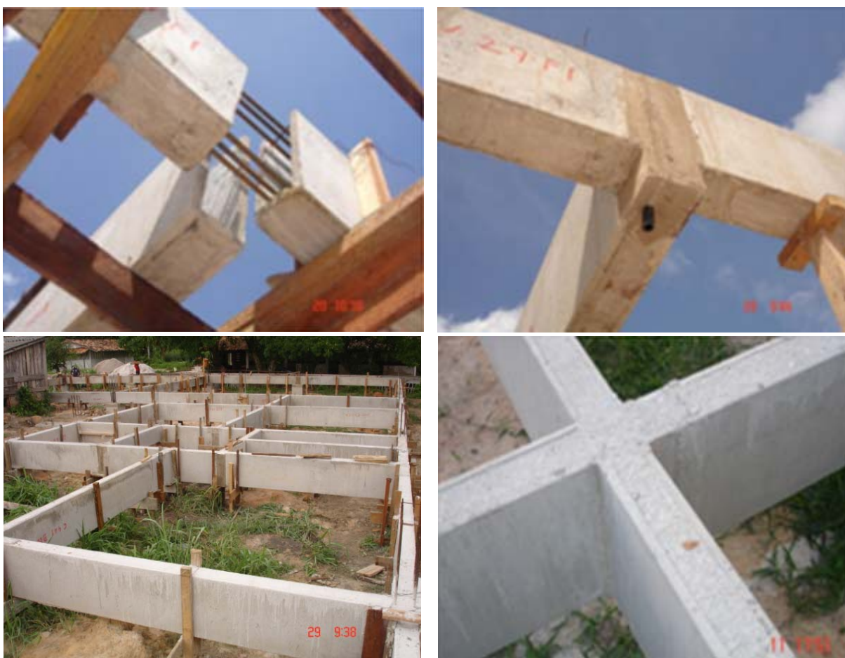
Figura 2.8 - Ligações entre vigas pré-formadas, durante a montagem e após a desforma
