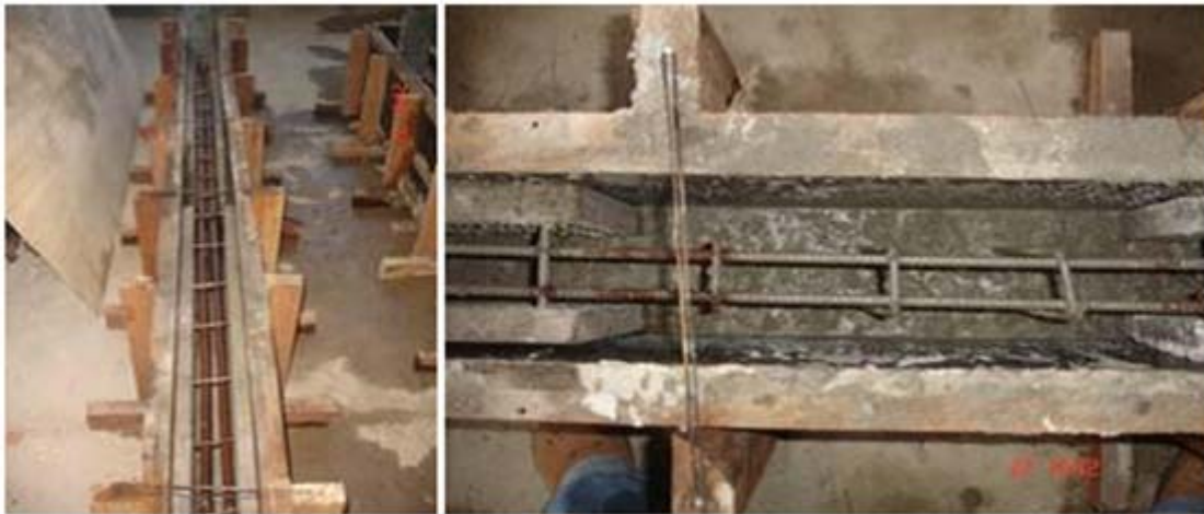
Figura 2.51 - Concreto da primeira fase (SOUZA et al., 2006)
