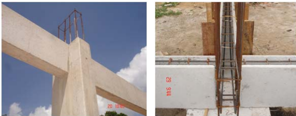
Figura 2.7 - Ligações de vigas pré-formadas com pilar
