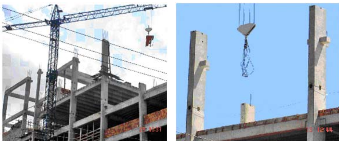
Figura 2. 1 - Equipamentos de montagem de pré-moldados (SILVA FILHO et al., 2006)
