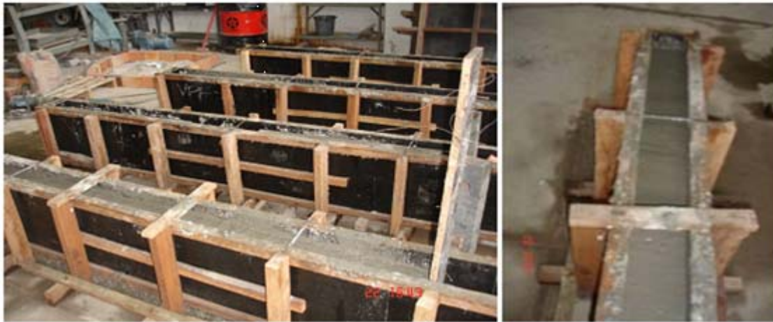
Figura 2.52 - Concreto da segunda fase e da viga maciça (SOUZA et al., 2006)
