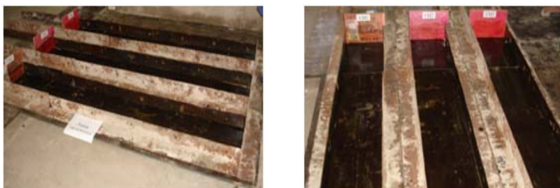
Figura 3.28 – Detalhes da forma das vigas maciças
