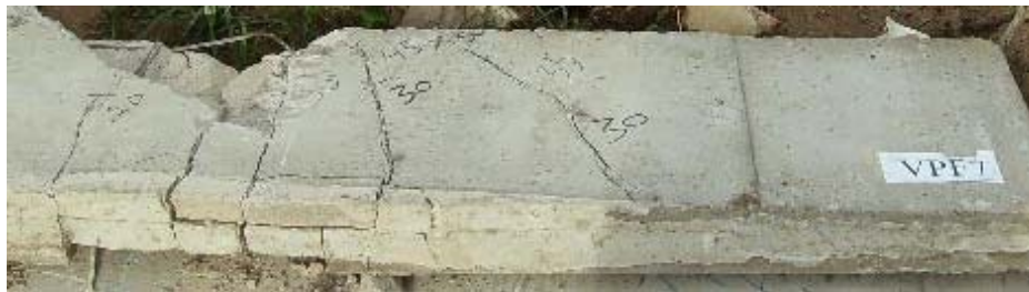
Figura 4.47 – Detalhes das camadas de concreto fissuradas nas mesmas seções VPF7
