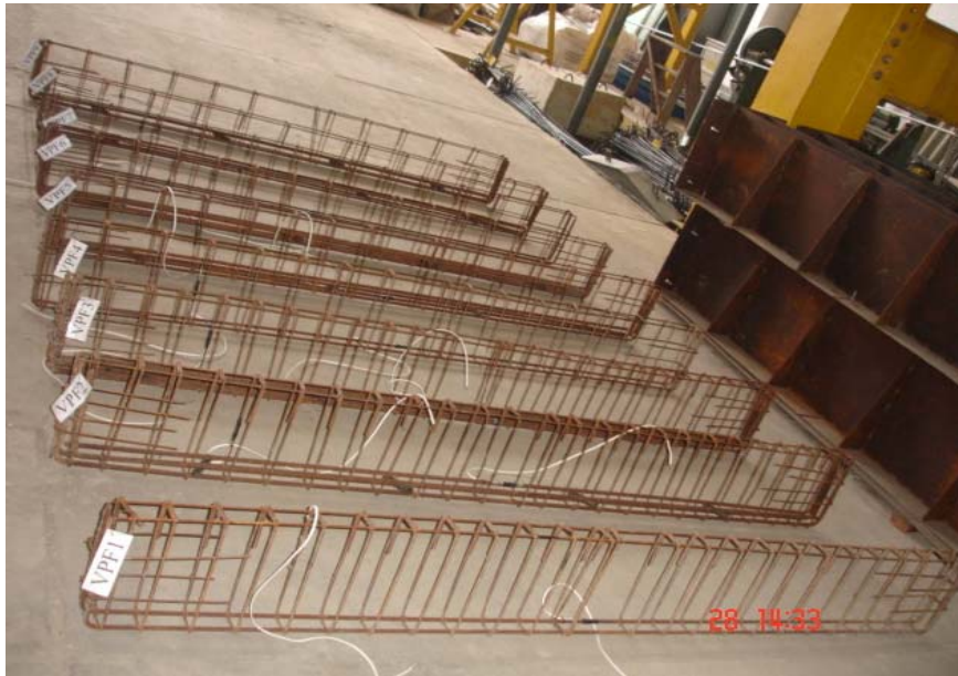
Figura 3.20 – Detalhes da armadura das vigas pré-formadas
