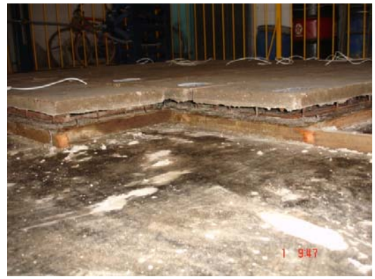
Figura 3.32 – Concretagem da segunda etapa (lateral 2)
